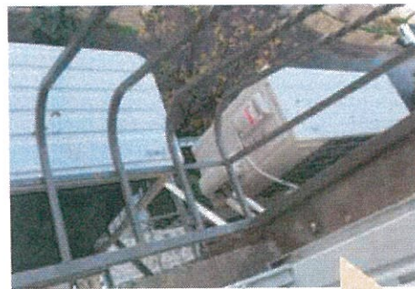
הליקוי: נטות המזגן המפוצל מעבר לחלון מסורג השכיחות: בינונית מה הבעיה: שירות וטיפול מצריכים הסרת הסורגים. בקומה גבוהה יצרוך מנוף או אפילו פיגומים (לא תמיד) וזאת הטכנאי לעתים הסורגים מותקנים על ידי הדיירים אחרי התקנת המזגן
